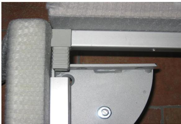
Il sistema brevettato da For Bed, utilizza uno speciale angolare di giunzione per l'assemblaggio delle barre, creato con una pasta di vetroceramica molto tenace che viene inserito nelle cavità delle verghe in alluminio ottenendo così un corpo unico tra fasce, pediera e testiera.
